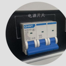
漏电空气开关
